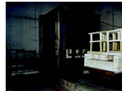
Lám. 8: detalle del horno y del sistema de raíles para la circulación de los carros, junto con los elementos refractarios para separar las piezas.
