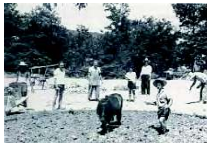
Típico sistema de amasar con pieiro y caballo en la pila del barro.
