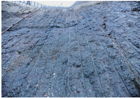
图3 预裂爆破后的拱肩槽边坡轮廓面
