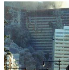
Η πτώση του κτιρίου 7
