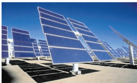
Obr. 13.13: Porovnání okamžitého výkonu systému bez a s naváděním a příklad panelů s dvouosým naváděním
