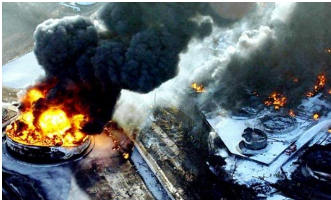
Obr. 5: Sklad ropných produktů, Buncefield, 2005 Následky výbuchu a vznícení zásobníku č. 912, Zdroj: http://www.hazards.org/
