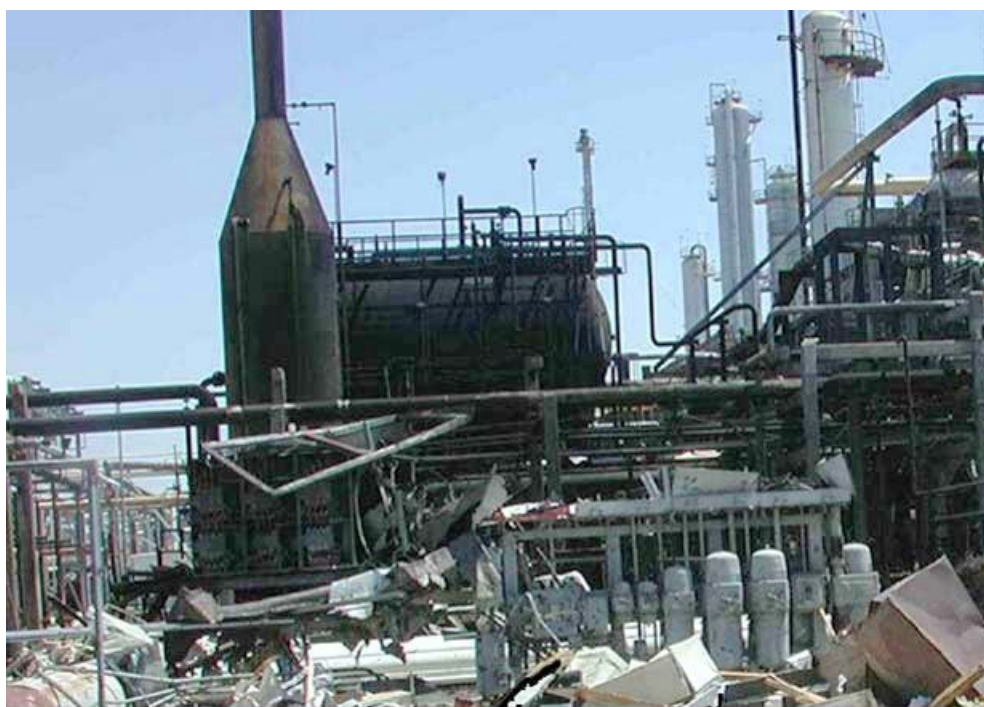
Obr. 3: Rafinerie BP, Texas City, 2005, Následky havárie v rafinerii společnosti BP.
