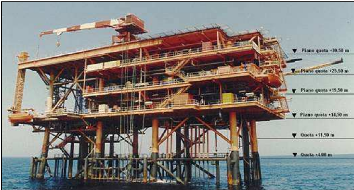
Figura 2.5 – Piattaforma RSM-B – stato di fatto.
