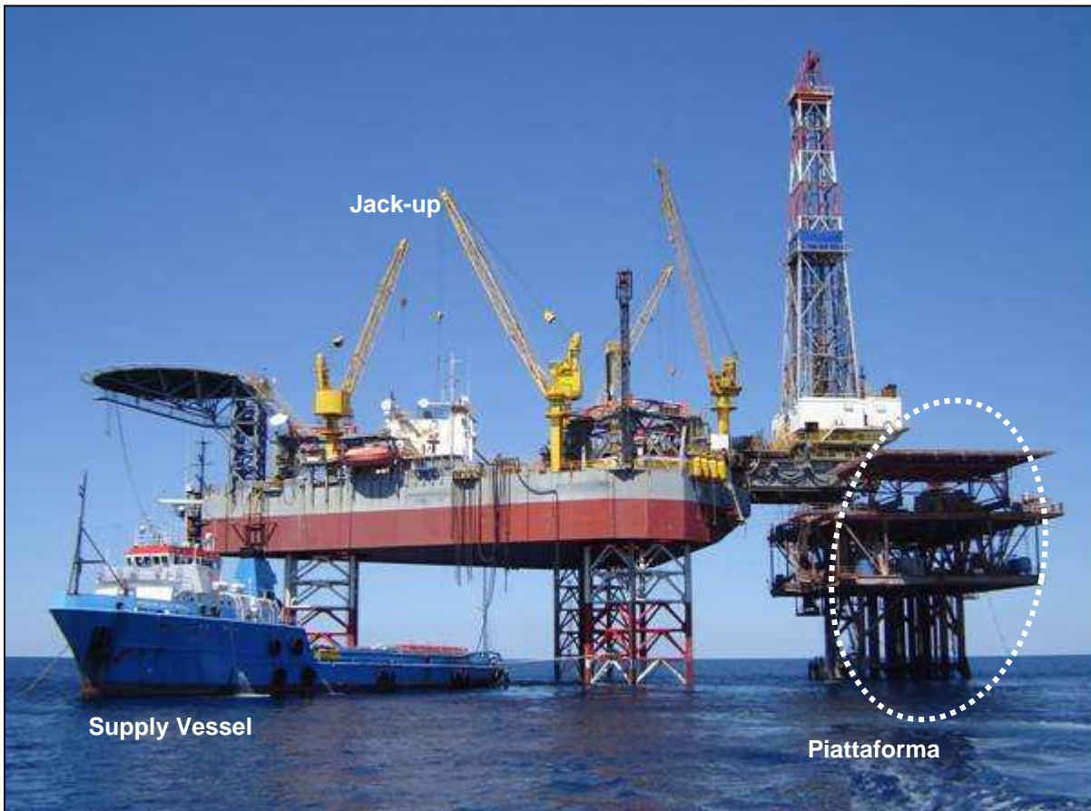
Figura 2.14 – Jack-up Drilling Unit posizionato presso una piattaforma.
