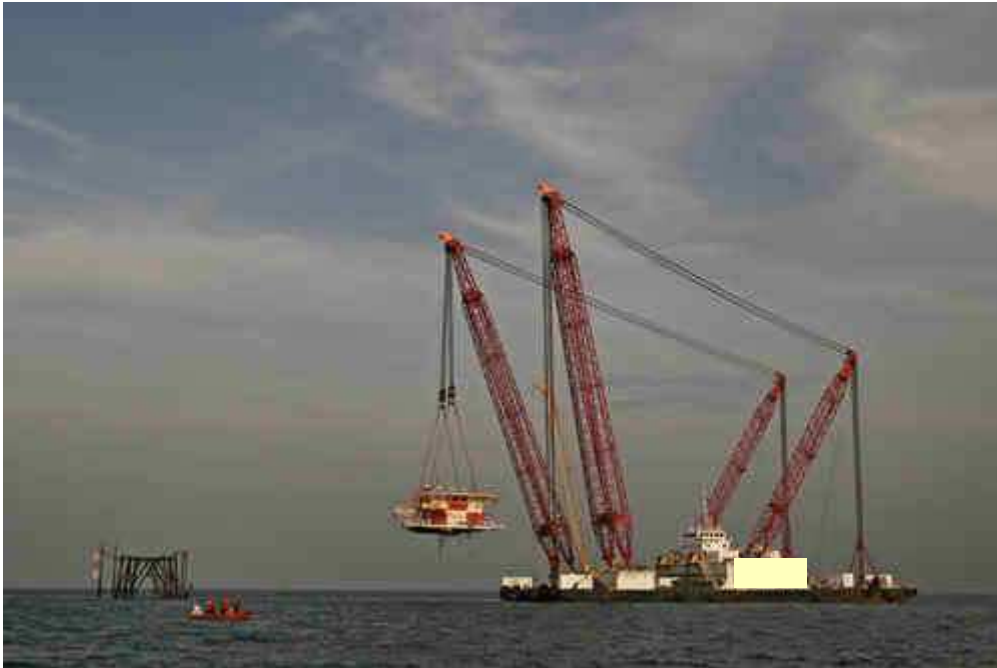
Figura 2.30 – Sollevamento di un Deck
