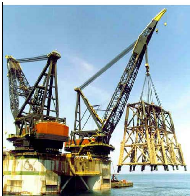
Figura 2.31 – Sollevamento completo di un Jacket
