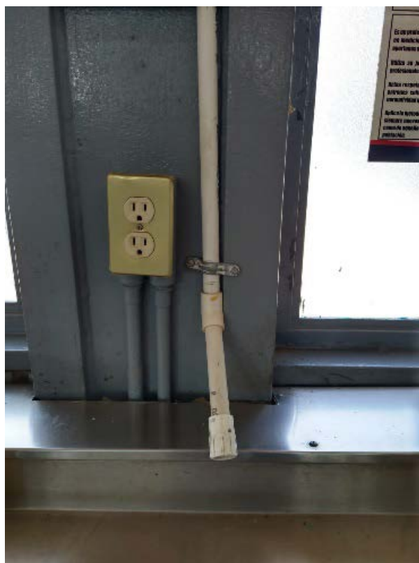
Imagen 17. Sistema de distribución de aire.
