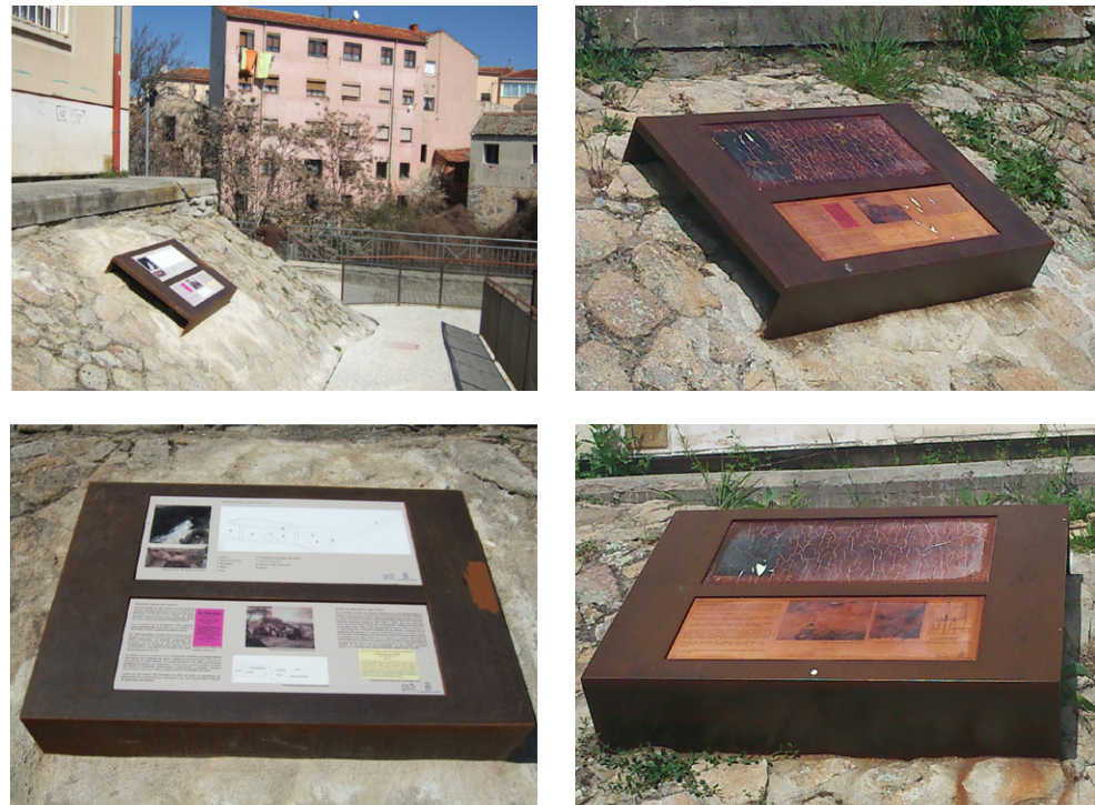
Izquierda, paneles informativos con contenidos geológicos instalados en las proximidades del molino Cavila; derecha, degradación de los paneles por insolación y efecto de la intemperie en materiales inadecuados, impidiendo su lectura.
