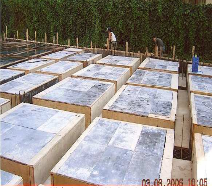
Kiriş-döşeme kalıbı hazırlanıyor
