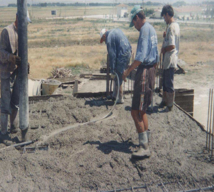
Kat betonu dökülüyor ve sıkıştırılıyor
