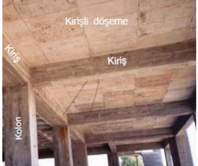
Kalıp söküldükten sonra alttan görünüş
