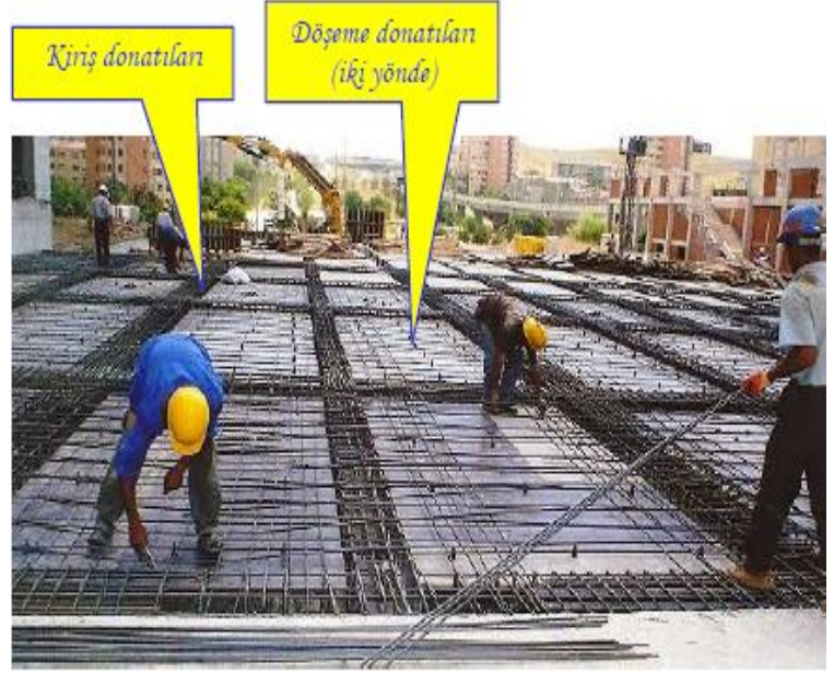
Kiriş donatıları yerleştirilmiş, döşeme donatıları yerleştiriliyor
