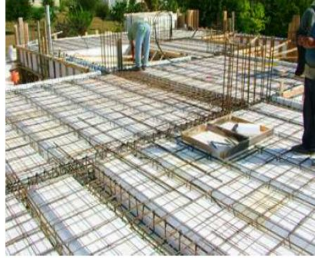
Yerinde döküm asmolen döşeme (bir yönde dişli, dişler arası dolgulu)
