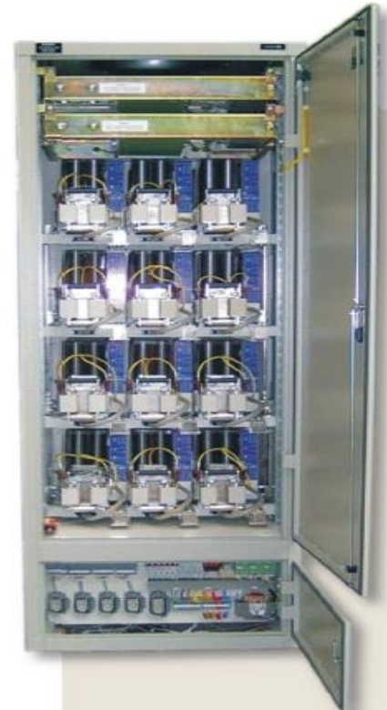
Pohled na instalované bloky v měniči VARIANT
