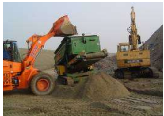
Figura IV.2.3.1.1- operazioni di vagliatura in sito.
