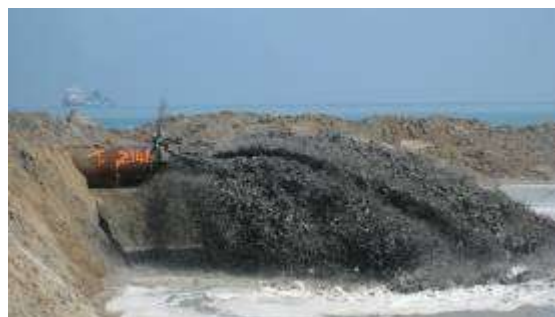
Figura IV.2.3.4.1- ripascimento con sabbie sottomarine
