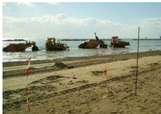
Figura IV.2.3.5.2 – ripascimento con “scraper” da accumuli di sedimenti in prossimità delle barriere
