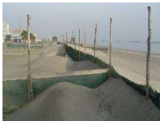
Figura IV.2.3.1.4- esempio di barriera frangivento stagionale
