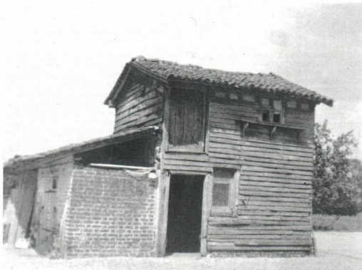
Chambre-à-four à Bailly-le-Franc.
