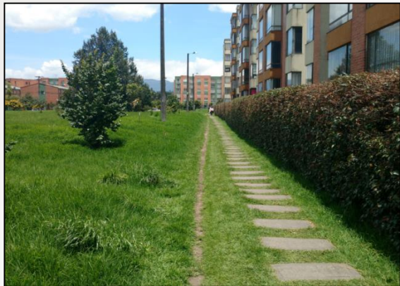
Sendero peatonal en losas discontinuas en concreto
