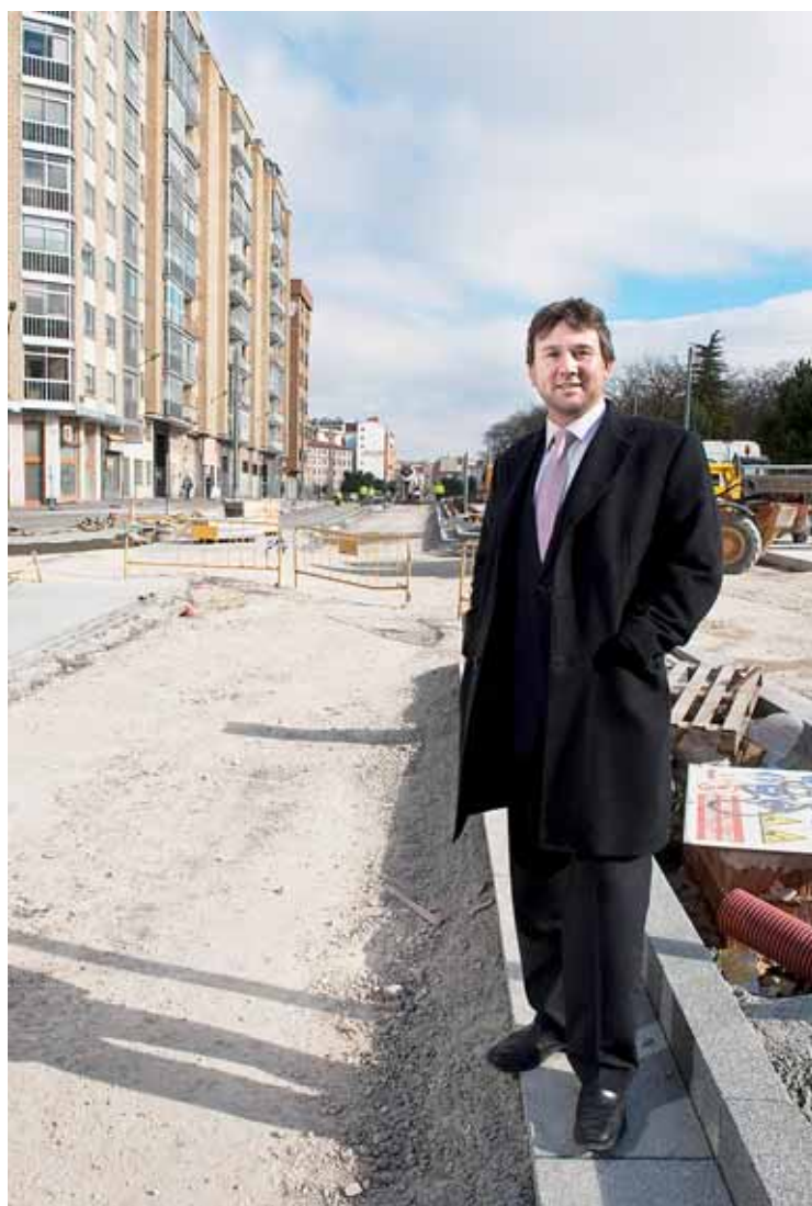
Es frecuente ver a Javier Lacalle comprobando el desarrollo de las obras del bulvar, el proyecto 'estrella' de cuantos tiene en marcha el Ayuntamiento.
