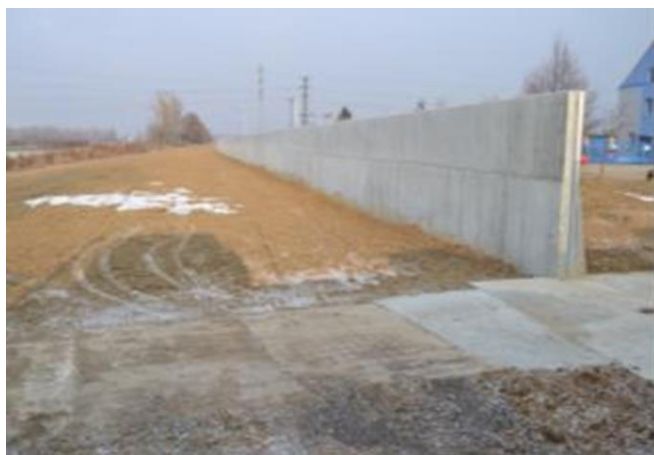
Protipovodňová stěna, dělicí Baťův kanál od Rybáren
