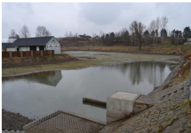
Odtokové zařízení (po rekonstrukci)
