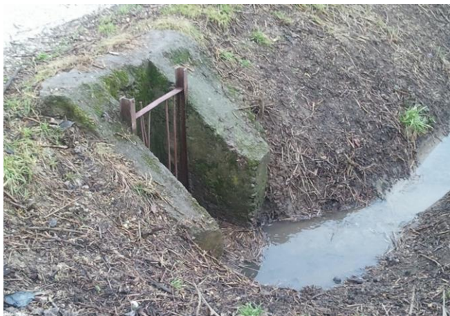
Vpust' ze strany přítokového kanálu
