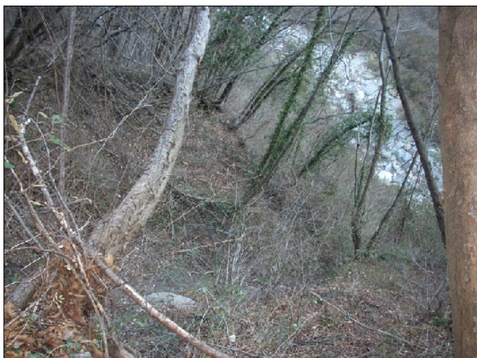
Fig. 7a: porzione settentrionale del coronamento a gennaio 2010; vista dall'alto.
