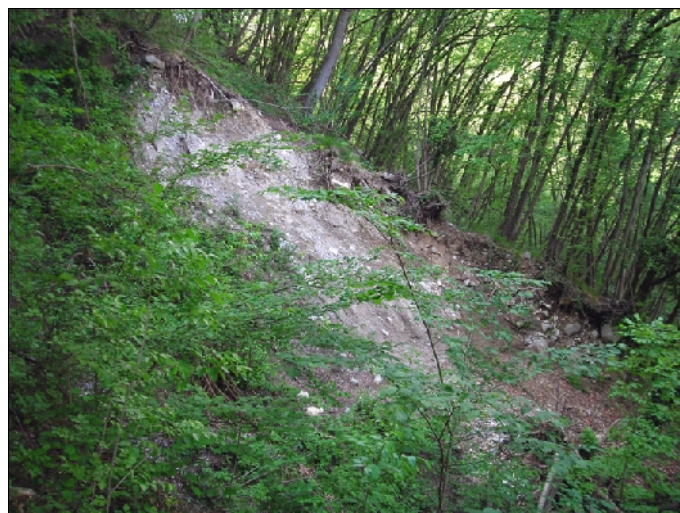
Fig. 7b: porzione settentrionale del coronamento a maggio 2012; vista di fronte. Confrontando la foto con quella di fig. 7a si nota come la nicchia si sia evoluta a causa di un espandimento laterale della stessa.
