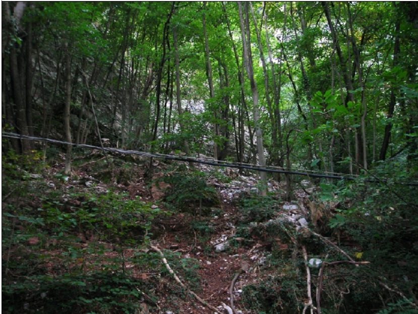
Fig. 20 (in alto): detrito instabile appena a monte della strada.
