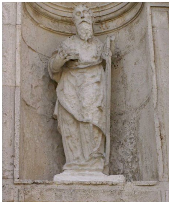
Ilustración 3. Procesos de alteración física que conducen a la erosión del material en la estatua de piedra caliza. Fuente: Lichtfouse y otros (2015) "Pollutants in Buildings, Water and Living Organisms Water Pollution". Springer International Publishing, Switzerland.
