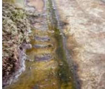
PISO CONCRETO CON UNA ZANJA PARA CAPUTAR EL LIXIVIADOS
