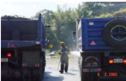
APLICACION DE EM AL COMIONES
