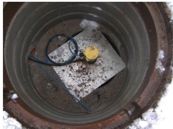
Bild 9: Einbau einer berührungslosen Messung auf der Beckendecke
