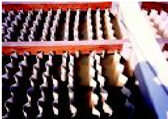
Figura 3-12. Floculador de pantallas de flujo horizontal (7)
