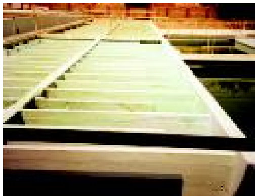
Figura 3-10. Floculador de pantallas de flujo horizontal (7)
