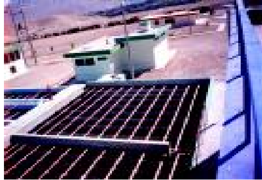
Figura 3-2. Floculador de pantallas de flujo horizontal (7)
