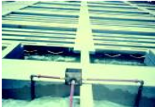
Figura 3-9. Floculador de pantallas de flujo horizontal (7)
