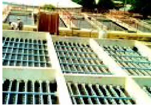
Figura 3-13. Floculador de pantallas de flujo horizontal (7)
