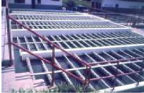
Figura 3-6. Floculador con pantallas de asbesto-cemento onduladas (7)
