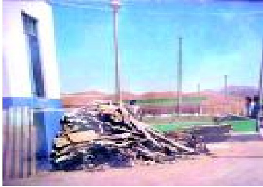
Figura 3-4. Pantallas de asbesto-cemento rotas (7)
