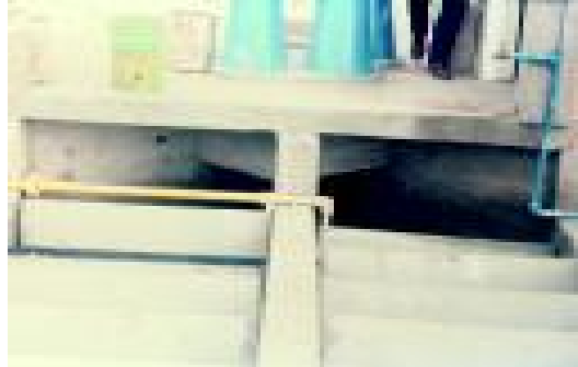
Figura 3-20. Floculador de flujo vertical (7)
