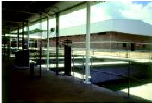
Figura 5-4. Batería de filtros de 1,0 m 3 /s de capacidad (1)
