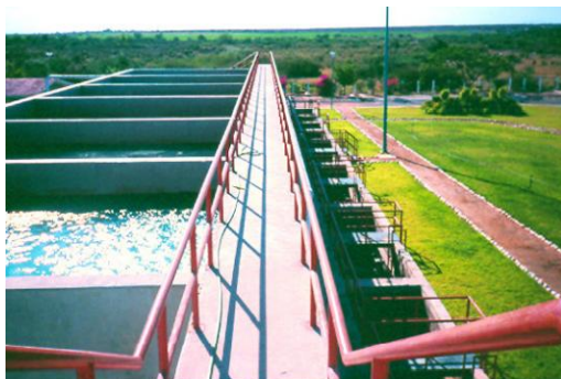
Figura 5-2. Baterías de filtros de tasa declinante con galería de tubos (1)
