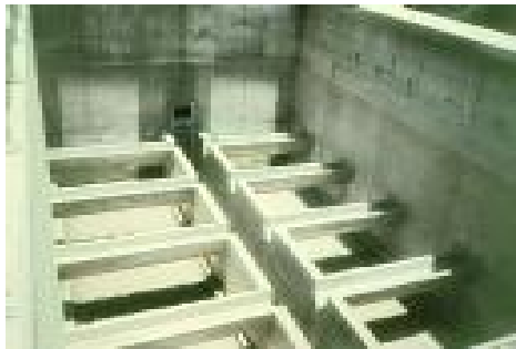
Figura 5-13. Canal principal central y canaletas secundarias laterales (1)
