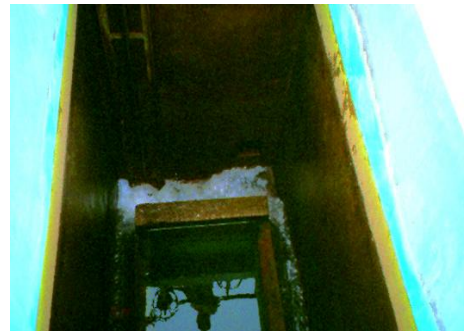
Figura 5-11. Canal principal frontal y canaletas secundarias (1)
