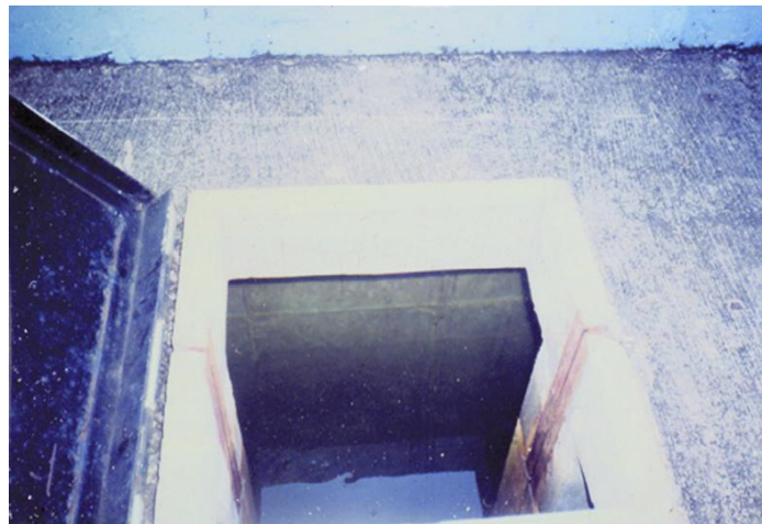
Figura 5-15. Vertedero calibrable de salida de la batería (I)
