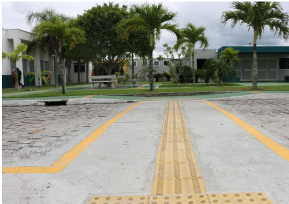
Figura 61 Construção e adequações de 240 m 2 de calçadas e 90 m de passeios adaptados para pessoas com deficiência e dificuldade de locomoção, atendendo à ABNT NBR 9050/2015 – Acessibilidade a edificações, mobiliário e equipamentos urbanos.
