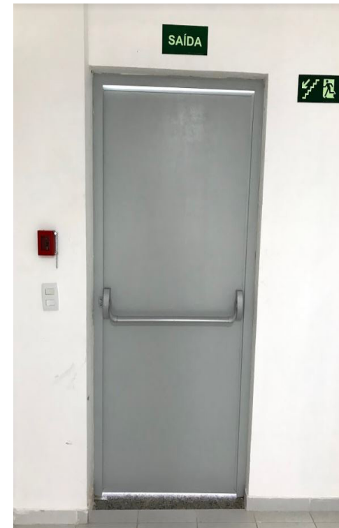
Figura 60 Substituição de sete (07) portas externas de vidro e alumínio do prédio do IIN-ELS por portas metálicas e corta-fogo com barras antipânico
