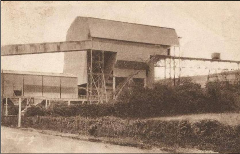
*Ci-contre, Le bâtiment achevé avec à droite l'extrémité de la passerelle avec un wagonnet. Arrivé au bout de la passerelle, il était déversé dans la goulotte du concasseur.*
