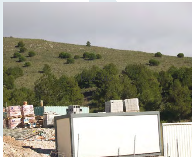
Zona en construcción en un entorno natural
