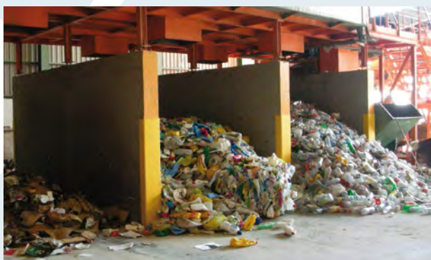
Separación de envases en planta de tratamiento de residuos
