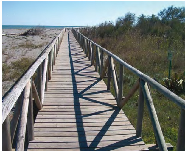
Pasarela de madera en el estuario del río Guadiaro (Cádiz).
