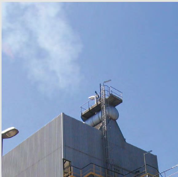
Emisiones de instalación industrial
