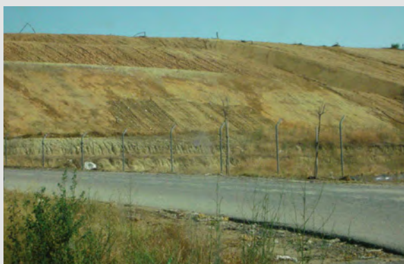
Vertedero de residuos no peligrosos
