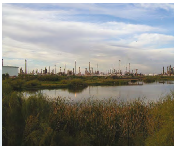
Vista de la refinería de La Rábida con la marisma en primer plano
