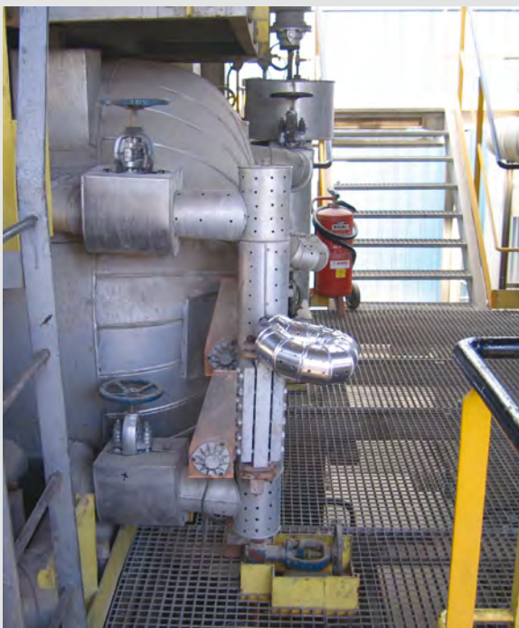
Contaminación acústica generada por maquinaria industrial
