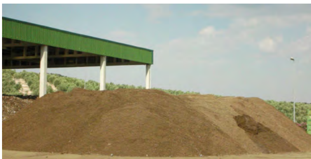
Zona de acopio de compost en instalaciones de tratamiento de residuos
