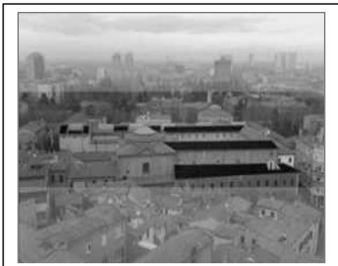
Fig. 1 - Studio per il progetto di riqualificazione energetica della Pinacoteca di Bologna tramite fotovoltaico integrato serigrafato (Tpiù2 Architetti Associati). Simulazione di pannelli fotovoltaici neri sulla copertura.
