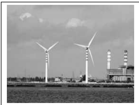
Fig. 1 - Prossimità di aerogeneratori a uno stabilimento industriale.
