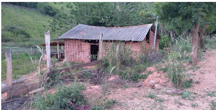
Figura 3 – Barracão que sediou a escola nos dois primeiros anos
