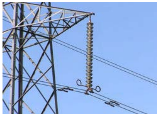
Obr. 11.19 Izolátor elektrického vedení pro VVN z tvrdého porcelánu
