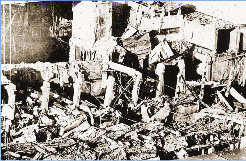
Zniszczone konstrukcje bloku
