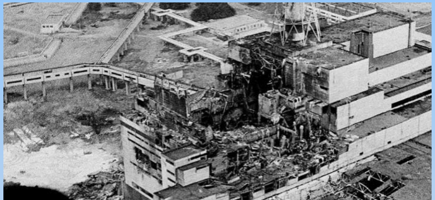
Zniszczony czwarty blok energetyczny Czarnobylskiej Elektrowni
