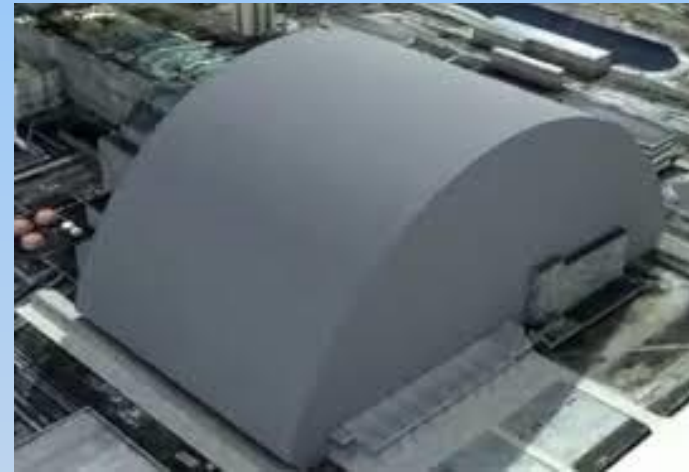
Nowe bezpiecznie schronienie (New Safe Confinement)
