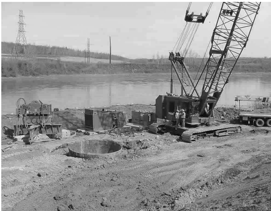
Obr. Stavební keson
