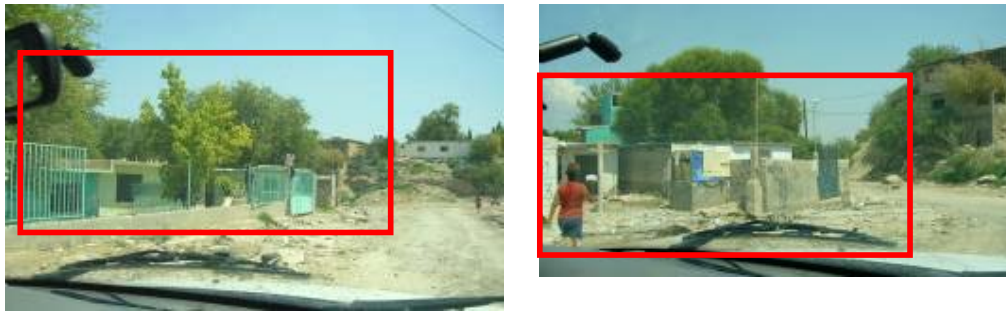
Figura 2.25 Daños aguas abajo del dique La Trituradora. Varias viviendas se encontraban dentro del cauce
