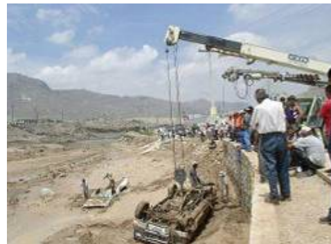
Figura 2.45 Afectaciones en el dique Los Ojitos
