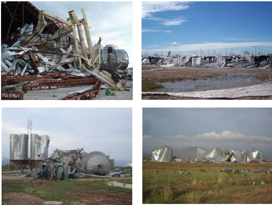
Figura 2.141 Daños en infraestructura agrícola
