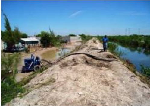
Figura 2.173 Bordo perimetral del dren El Anhelo
