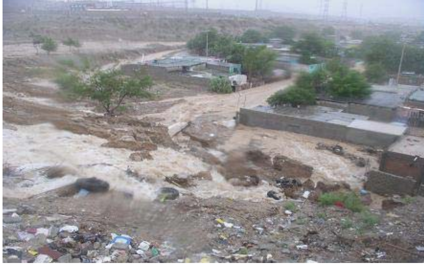
Figura 2.38 Desbordamiento del dique La Montada sobre la Colonia Fronteriza Baja
