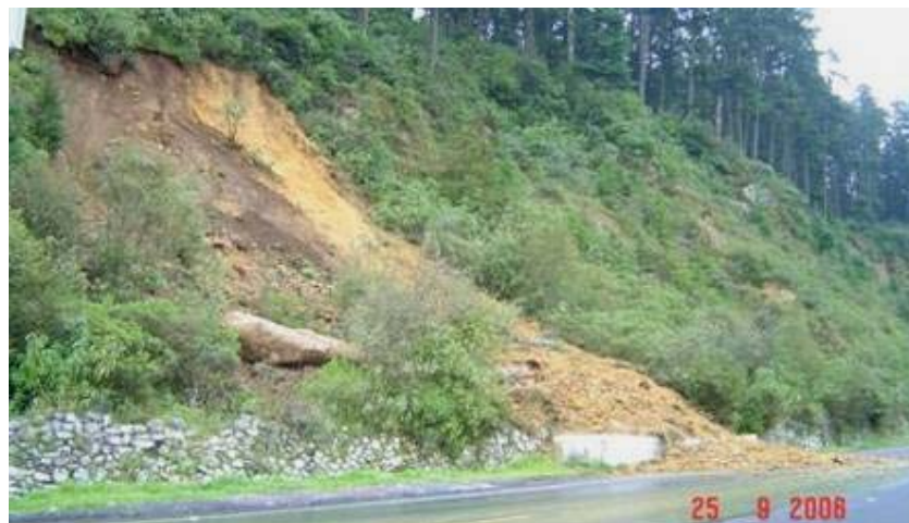
Figura 5.5 Vista del tercer deslizamiento ocurrido en la mañana del 25 de septiembre
