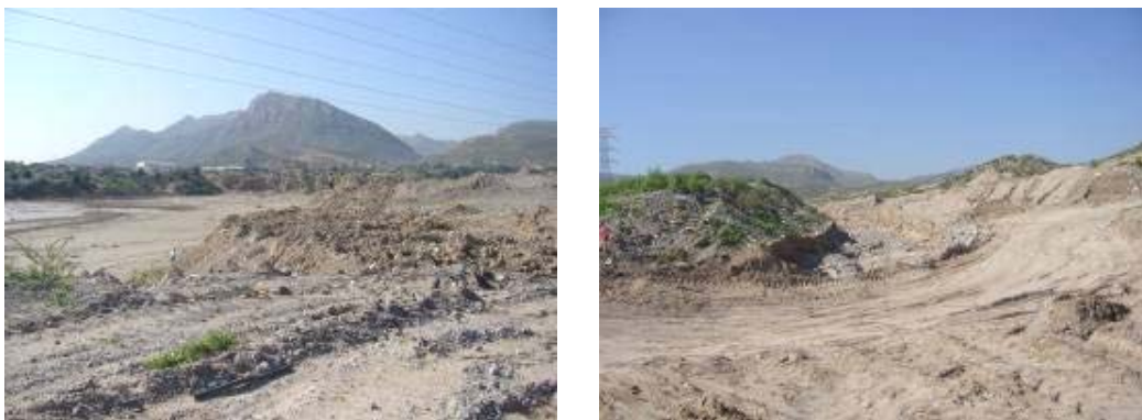
Figura 2.21 Tajo abierto aledaño al dique La Fronteriza. Vista desde la margen izquierda y en su recorrido
