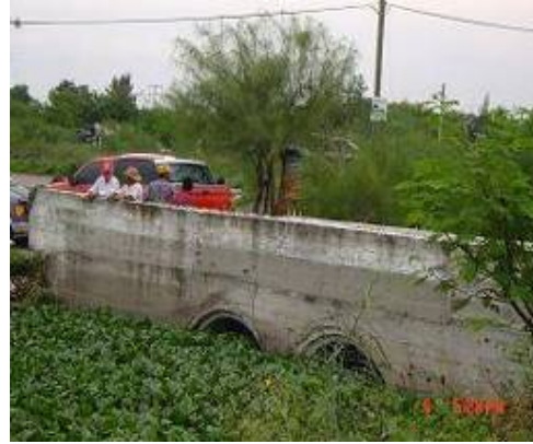
Figura 2.198 Dren Río Bravo, municipio Río Bravo donde se observó obstrucción por lirio acuático
