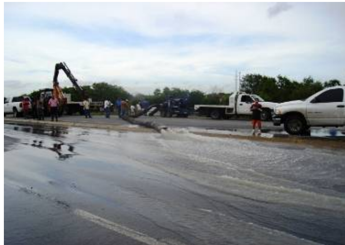
Figura 2.187 Bombeo hacia el canal Anzaldúas
