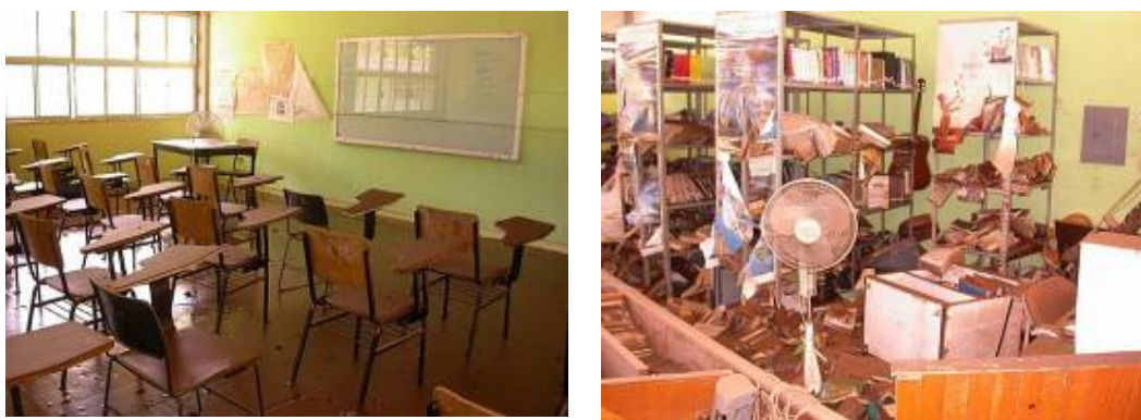
Figura 2.76 Daños en mobiliario y aulas de escuela secundaria del municipio de Mulegé
