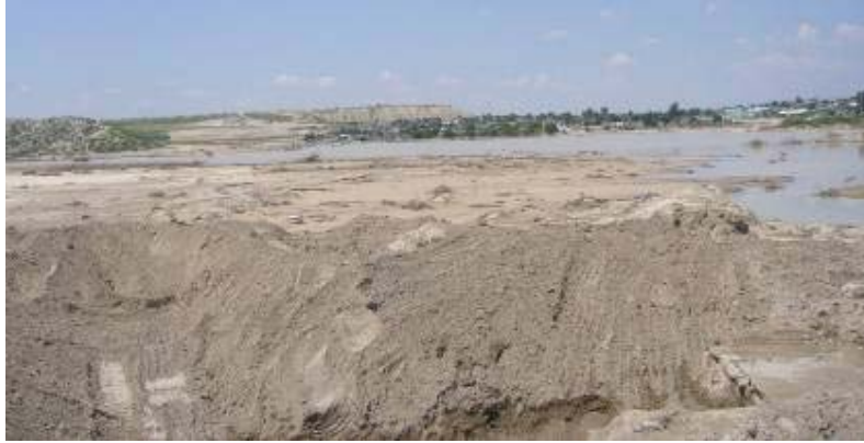
Figura 2.27 Azolves en la vecindad de la obra de toma de la presa Benito Juárez
