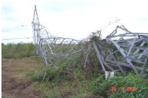
C. Derrumbe de torres de transmisión de la CFE en la comunidad de Quila, Culiacán
