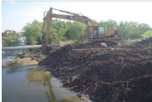
Figura 2.175 Trabajos de dragado en el dren El Anhelo
