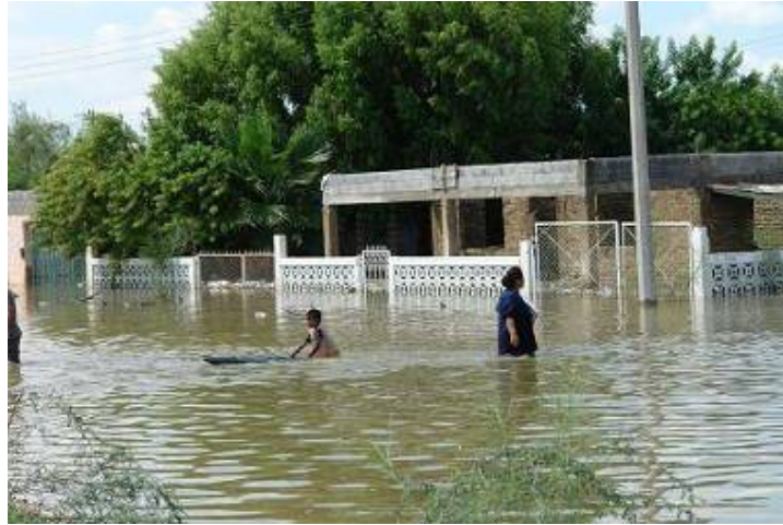
Figura 2.191 Colonia inundada a causa de la lluvia en el municipio de Reynosa
