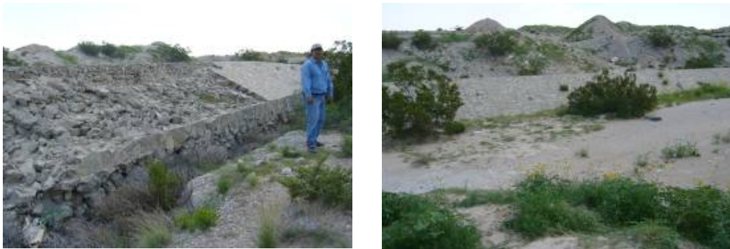
Figura 2.28 Canal de descarga de la presa Benito Juárez
