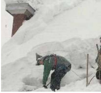
Figura 7.6 Acumulación de nieve en techos a causa de las fuertes nevadas en Europa del Este
