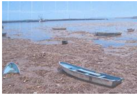
Azolvamiento en dársena
