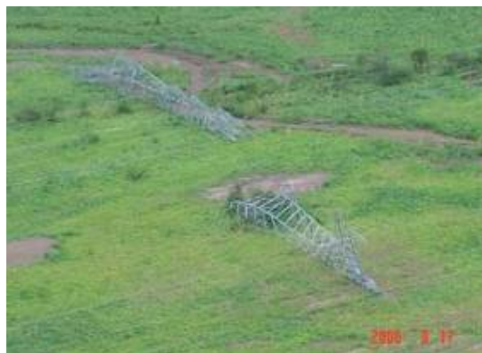
Figura 2.135 Daños en líneas de alta tensión a causa de los fuertes vientos originados por Lane
