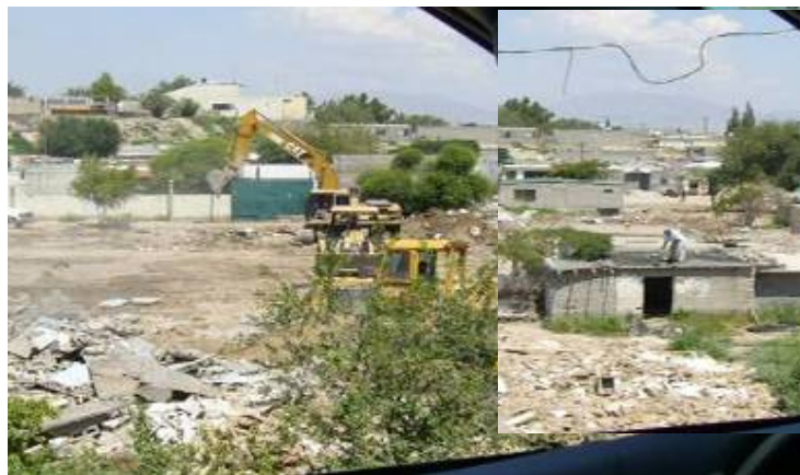
Figura 2.26 Demolición de viviendas ubicadas sobre el cauce, aguas abajo del dique La Trituradora
