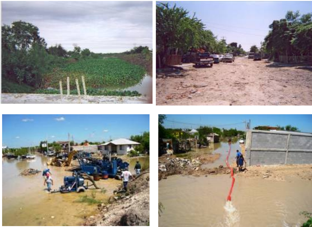
Figura 2.168 Problemática debida a la carencia o mal estado del sistema de drenaje
