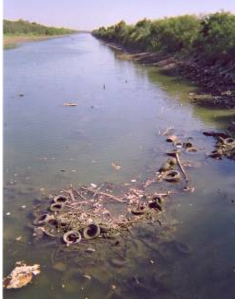
Figura 2.171 Reducción de la capacidad de conducción del dren Anzaldúas, debido a la gran cantidad de basura
