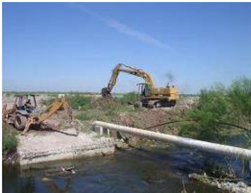
Figura 2.299 Demolición de puente que obstruía el paso del agua en el Dren El Anhelito
