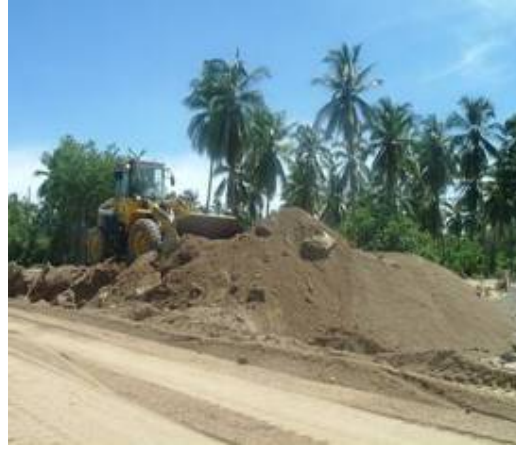
Figura 2.153 Labores de desazolve
