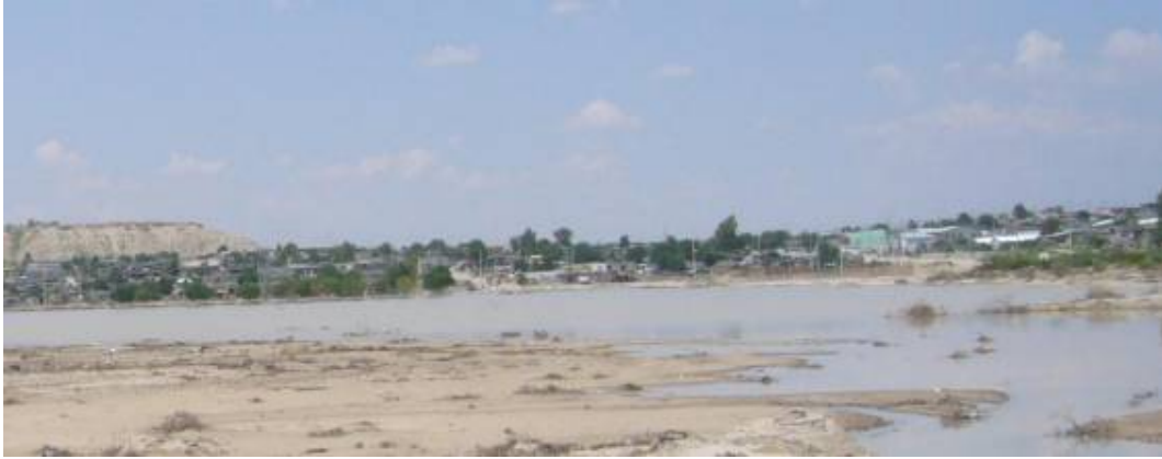
Figura 2.17 Vista de los asentamientos dentro de la presa Benito Juárez
