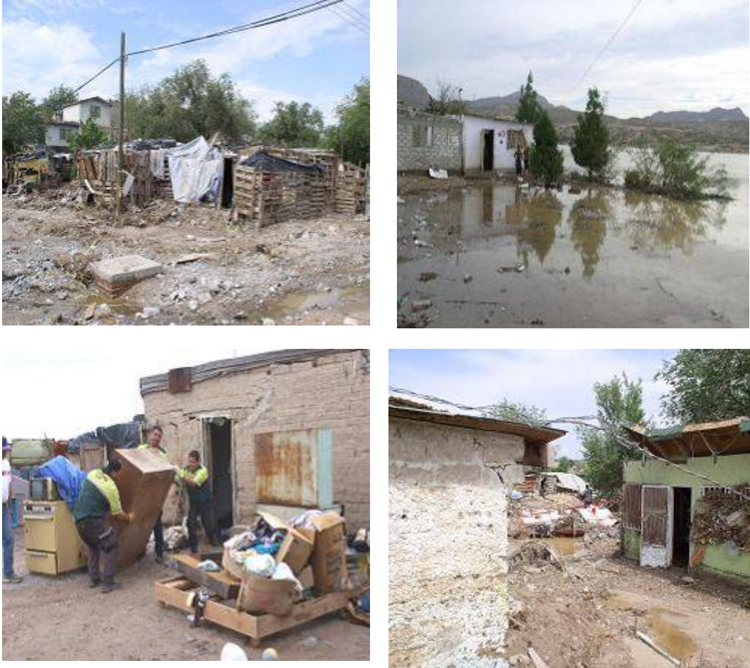
Figura 2.42 Viviendas con diversas afectaciones
