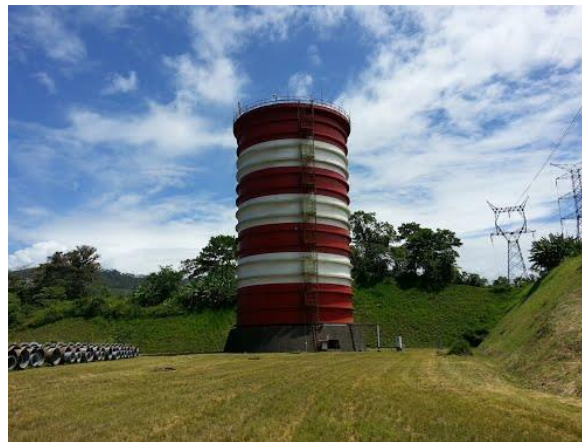
Figura I.11 Torre de oscilación de 52 m de altura (proyecto hidroeléctrico Reventazón, Costa Rica)
