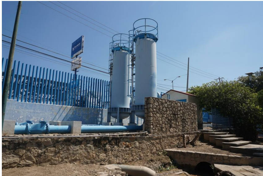
Figura VI.1 Cámaras de aire en el sistema Cayaco-Renacimiento
