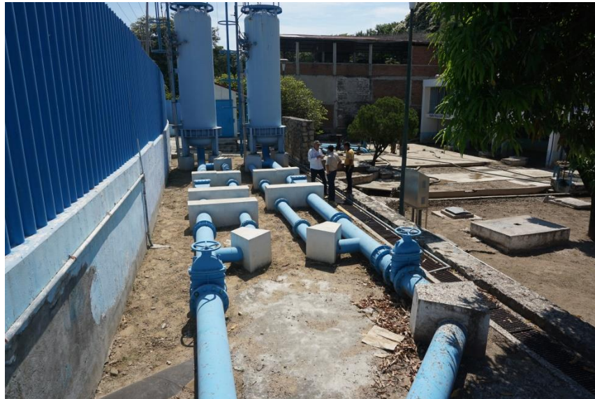
Figura VI.2 Conexiones con las cámaras de aire
