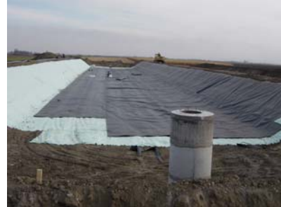
Slika 1. Primena geomembrane i geotekstila: kanal za navodnjavanje u Srpskom Miletiću (levo) i laguna u Magliću u izgradnji primenom geotekstila i geomembrane (desno)
