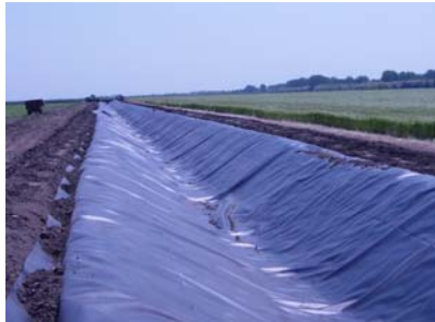
Slika 1. Primena geomembrane i geotekstila: kanal za navodnjavanje u Srpskom Miletiću (levo) i laguna u Magliću u izgradnji primenom geotekstila i geomembrane (desno)
