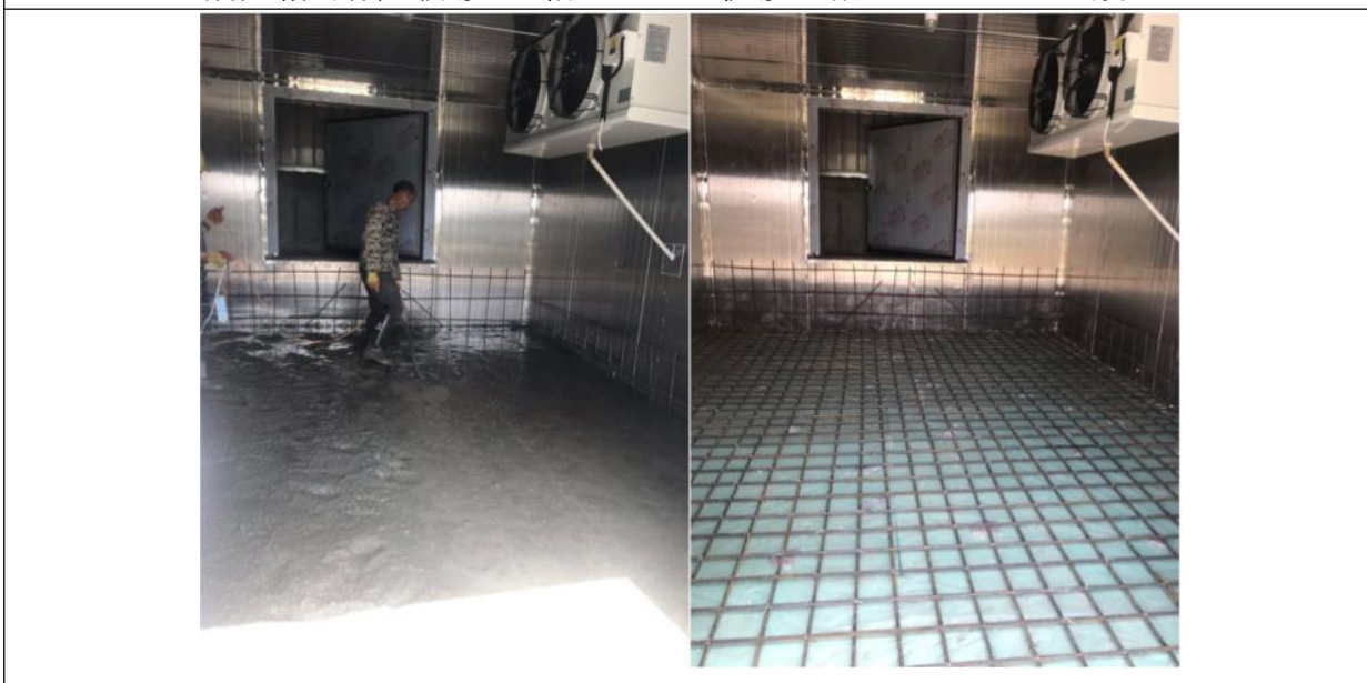
病死猪冷藏室防渗（“粘土+35cm 抗渗混凝土+2mmHDPE 膜”）
