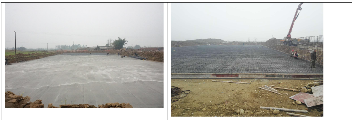
病死猪冷藏室防渗（“粘土+35cm 抗渗混凝土+2mmHDPE 膜”）
