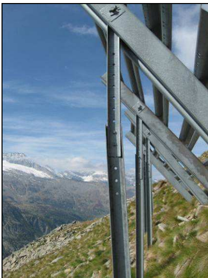
Immagine 10 :esempio di elementi disallineati e ruotati con fondazione di monte inadeguata.
