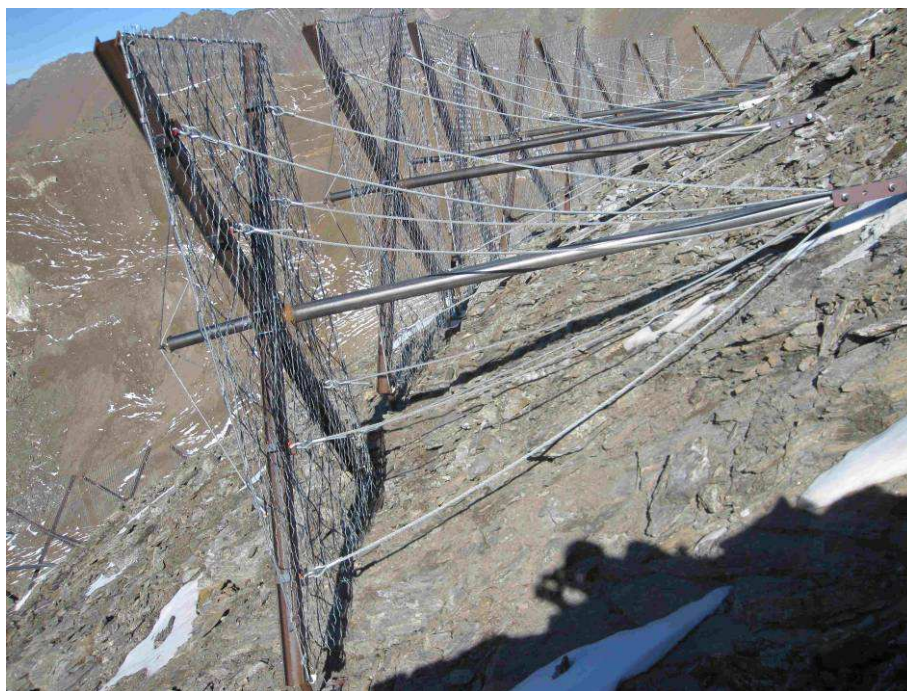
Immagine 13 :esempio di elementi ad ombrello (cantiere Licony Cogne)
