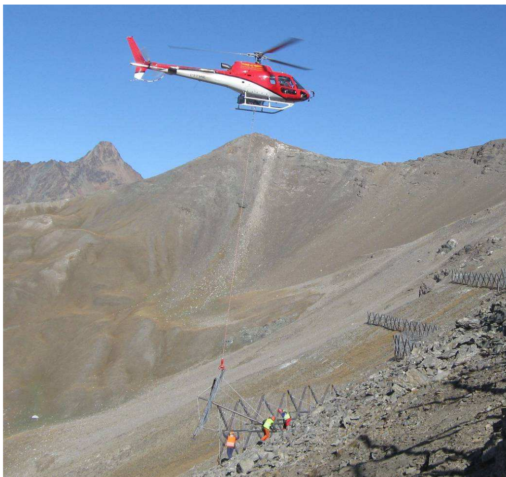
Immagine 14 : posa di paravalanghe ad ombrello (cantiere Licony Cogne)
