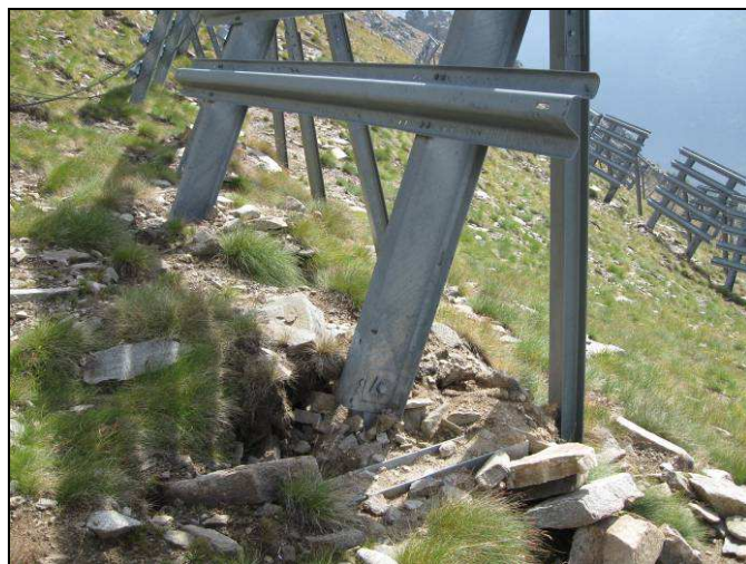
Immagine 10 :esempio di elementi disallineati e ruotati con fondazione di monte inadeguata.
