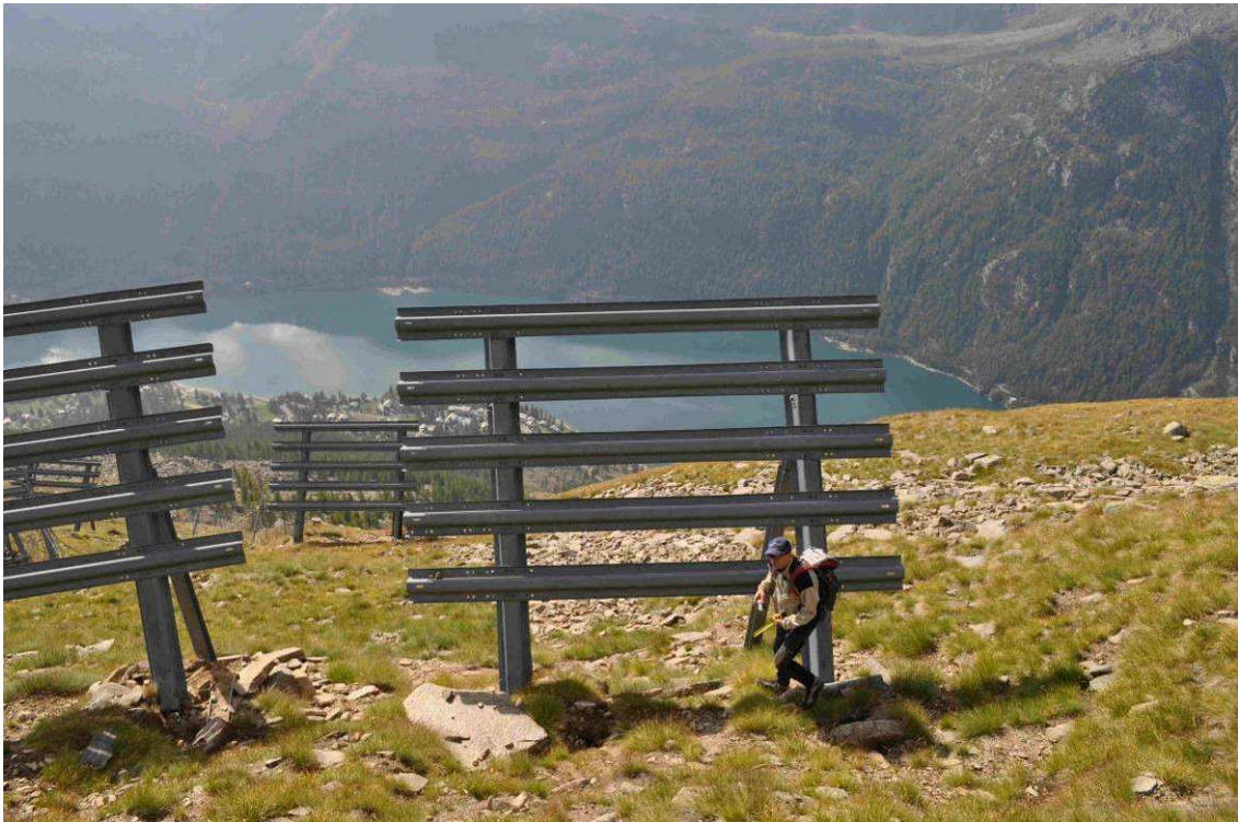
Immagine 11 : esempio di elementi con eccessivo spazio tra terra e prima traversa.
