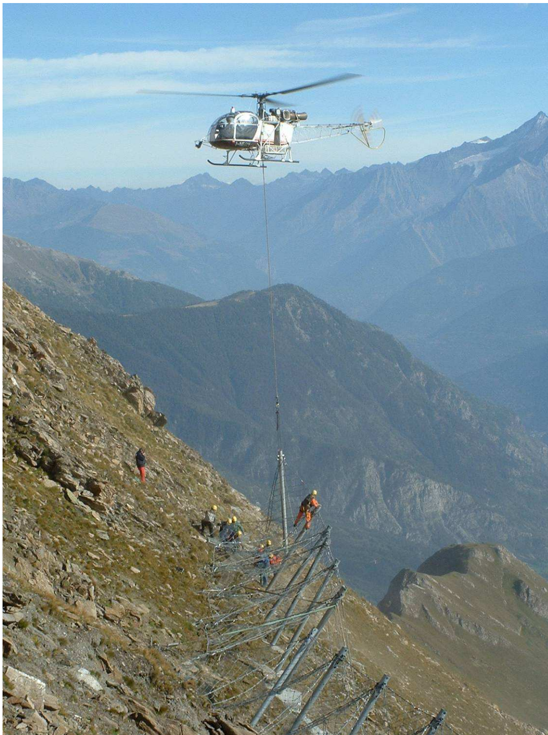
Immagine 3 : complessa operazione di montaggio delle barriere che in questo caso provengono da un allestimento in piazzale. (cantiere Lavancher AO)
