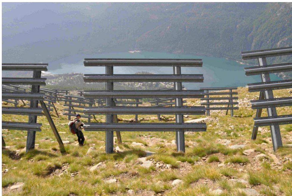
Immagine 12 :esempio di elementi con varchi eccessivi (Fila 4)
