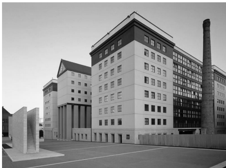
Figura 21. Vista de la plaza interior y elevada del conjunto. Tomada de: https://s-mediacache-ak0.pinimg.com/originals/b8/18/7c/b8187c0b72bfa86d10e8ea87a9c2e874.jpg
