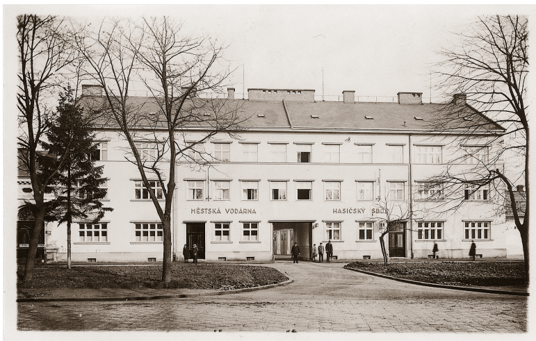
Správní budova městské vodárny roku 1932.
