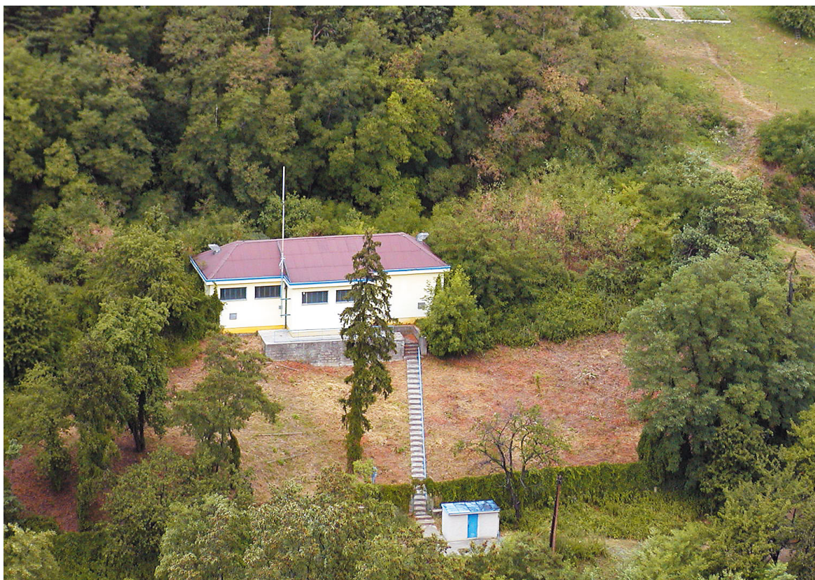
Vodojem Čekyně, 5 000 m 3 .
