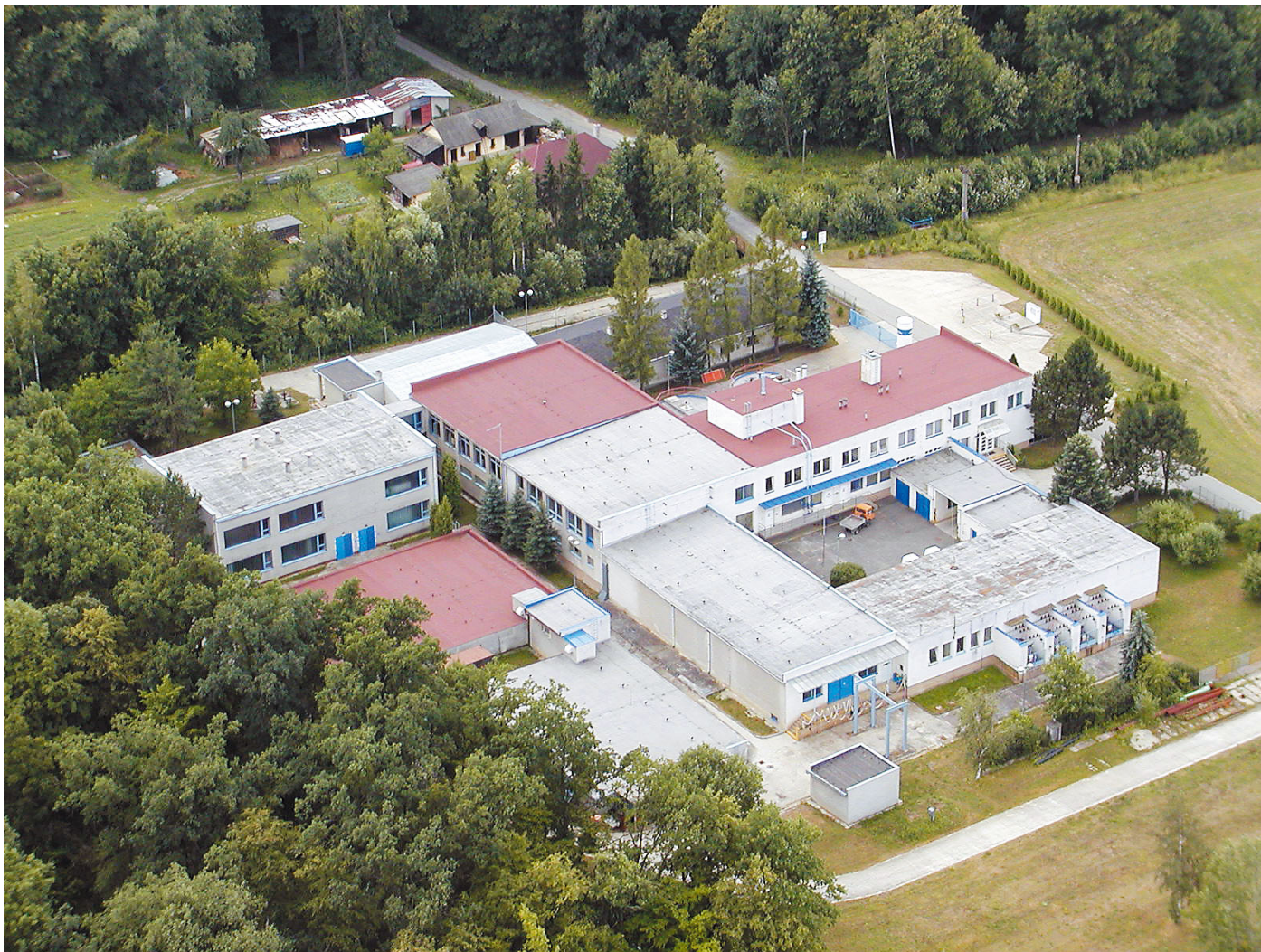
Úpravna vody Troubky.
