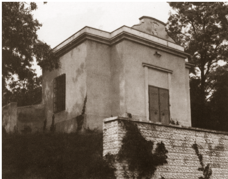
Vodojem na Čekyňském kopci v roce 1926.
