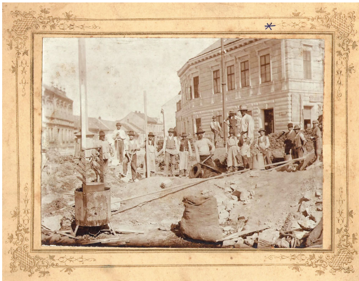
Kladení vodovodního potrubí na křižovatce Komenského ulice, Trávnicku a Šířavy v roce 1903. Třetí zprava Kliment Sýkora.
