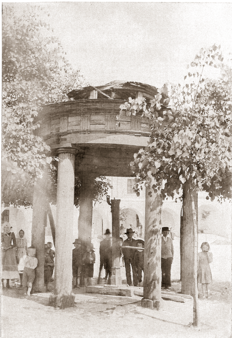
Dřevěný pavilón na Horním náměstí s pumpou. Foto z konce 19. století.
