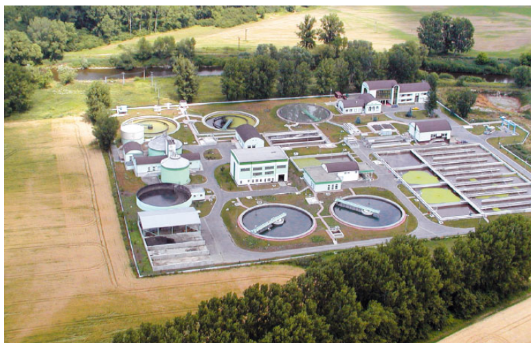
ČOV Přerov po dokončení rekonstrukce v roce 2001.
