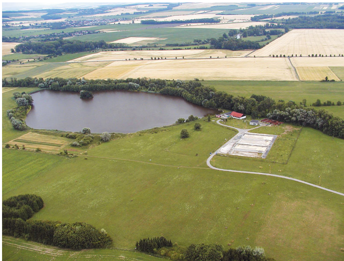
Úpravna vody Lýsky – zásobní rybník a filtrační stanice.
