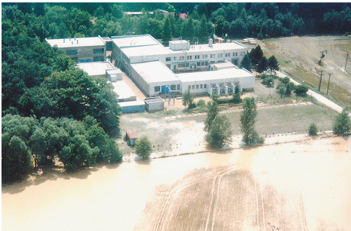
Úpravna vody Troubky při povodni v červenci 1997.
