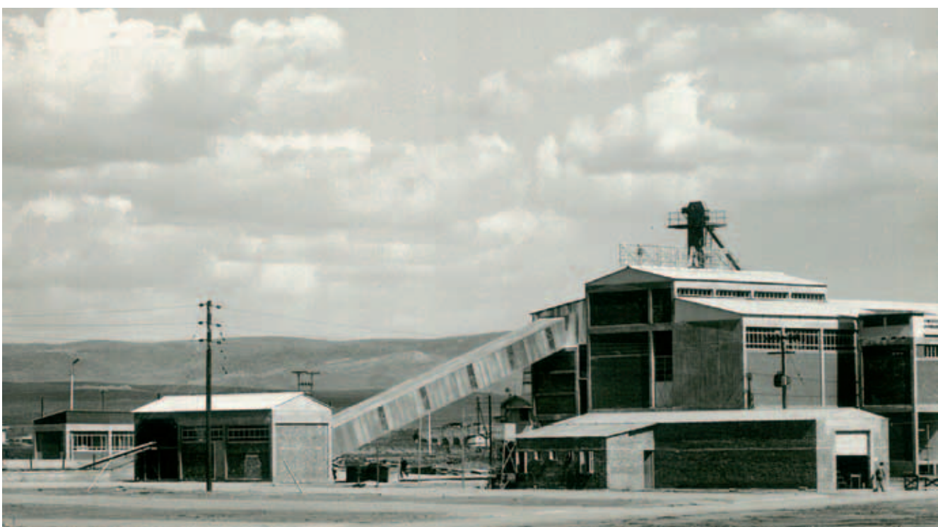
Το εργοστάσιο της Ξυλοπάν Α.Ε. Το 1970 και το 1973 πραγματοποιήθηκαν νέες επενδύσεις στις εικονιζόμενες εγκαταστάσεις.
