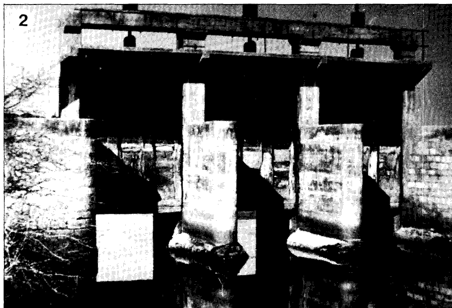
Photo 2 - Le vannage du Porteau sur l'étier du Pont-Angelier, ouvert lors de l'évacuation d'eau douce.
