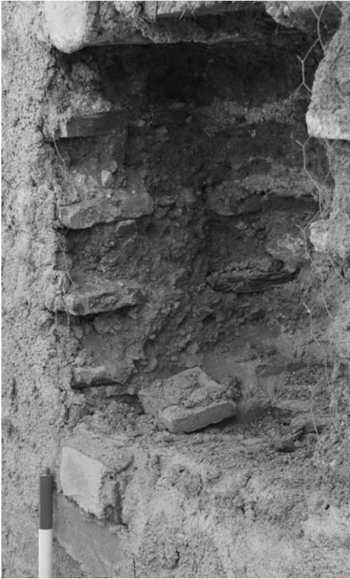
Figura 3 Interior cajón tapia valenciana. Guadix
