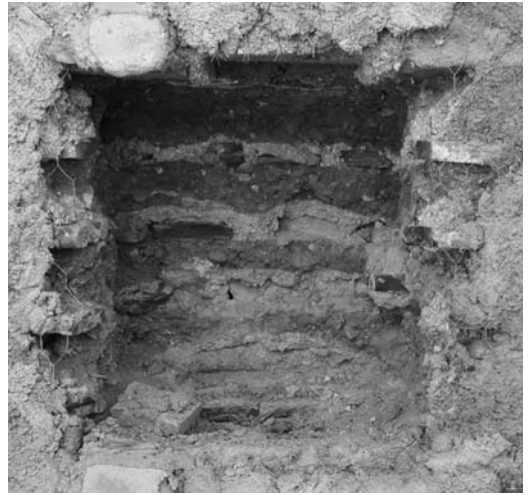
Figura 4 Interior cajón tapia valenciana. Guadix
