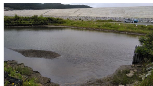
陸側の沈殿池（A1の東側）
