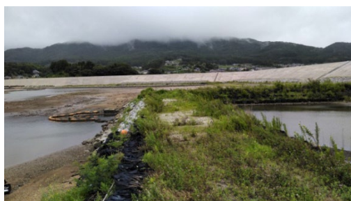
陸側の沈殿池（A1の東側）
