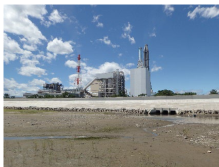
後背地の火力発電所と防潮堤。A1 地点 近傍の暗渠から河川水が流入している。
