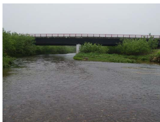
調査地点 No.1 から下流の状況
