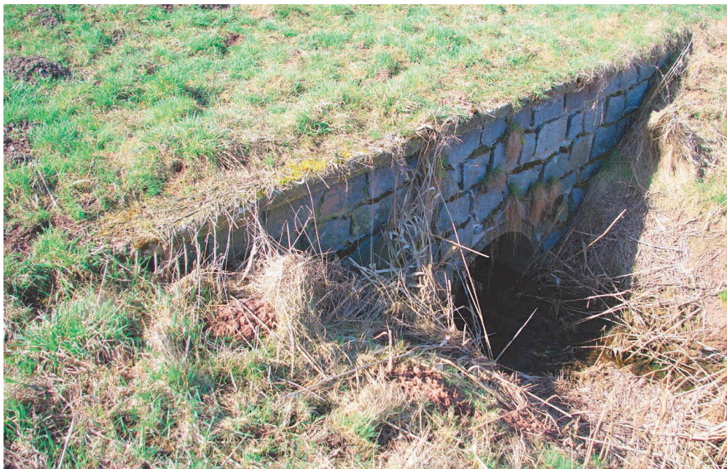
Obr. 6. Do současnosti dochované stavidlové objekty a propustky. (Foto: VÚV).
