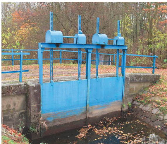
Obr. 7. Dílčí objekty závlahové soustavy v soudobém stavu (shybka, akvadukt, stavidlový uzávěr, typizované čerpací stanice. (Foto: VÚV).
