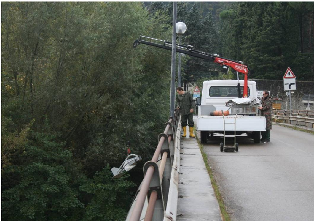
Figura 2-1: Mezzo con braccio gru meccanizzato durante le operazioni di calata dell'Helley Smith sul Fiume Arno a Nave di Rosano.
