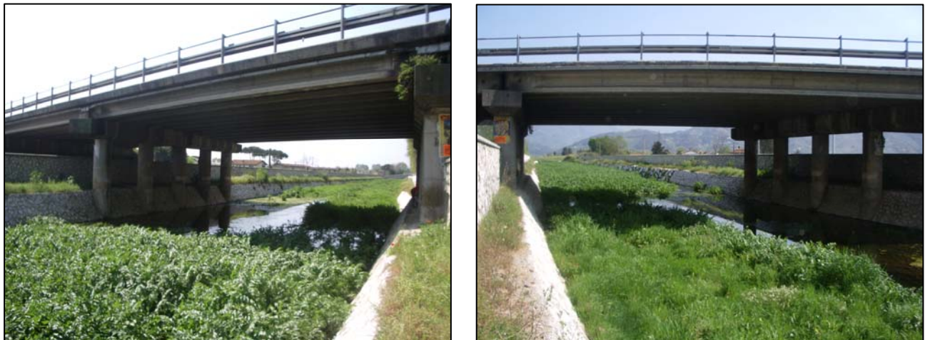
Figura 5-24: Il sito di campionamento sedimentologico sul f. Camaioire; (a sinistra: vista da monte verso valle; a destra: vista da valle verso monte).
