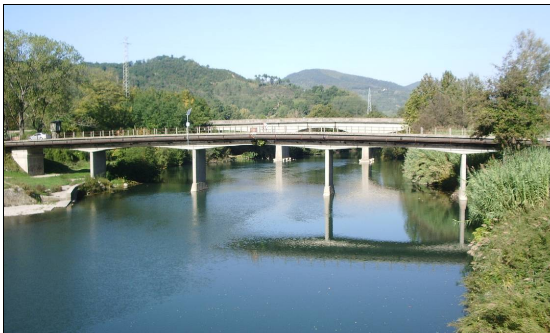
Figura 5-1: Fotografia del ponte di Ripafratta sul fiume Serchio ove è collocata la stazione di monitoraggio del trasporto solido.
