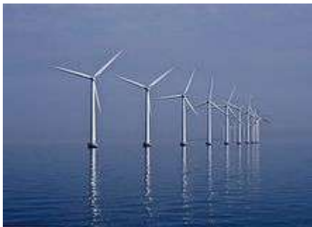
Middelgrunden, impianto eolico da 40 MW nello stretto di Oresund al largo di Copenaghen.
