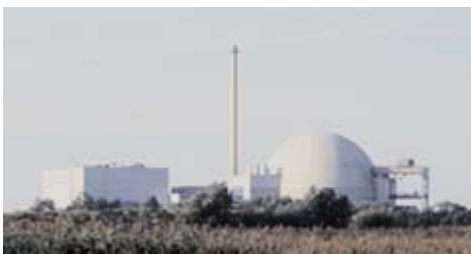
Unterweser (Esenshamm) Nuclear Power Plant
