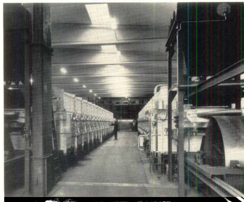
Det nya järnsvampsverket i Höganäs är ett mönster för en modern fabriksanläggning. Vi ser här de två nya reduktionsugnar, som togs i drift under fjolåret.
