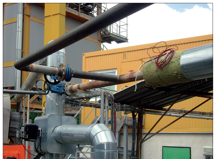
Obr. 6 Vyhřívání a tepelné izolace potrubních rozvodů asfaltu
