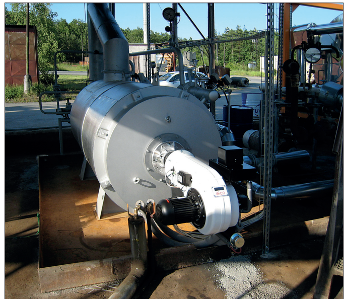
Obr. 5 Hořák Elco EK4.100 L-RO s elektrickým ohřevem LTO
