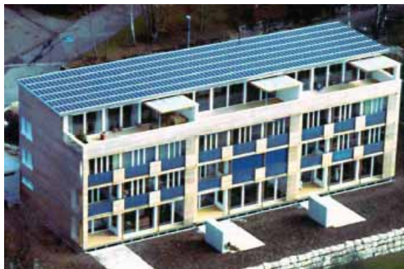
Σχήμα 3.37. Εφαρμογές φωτοβολταϊκών στοιχείων σε διαφορετικούς τύπους επιστέγασης κτιρίων.
