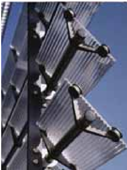
Φωτ. 3.5. Χρήση των πρισματικών πετασμάτων για τη διαμόρφωση ηλιοπροστατευτικών διατάξεων σε ανοίγματα. ( www.inqlas.de ).
