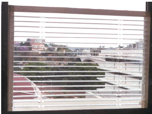
Φωτ. 3.7. Άποψη του ειδικά επεξεργασμένου με λέιζερ υαλοπίνακα από τον εσωτερικό χώρο. ( www.siteco.com ).
