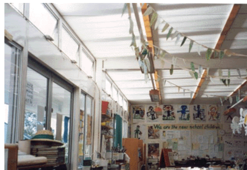
Φωτ. 3.8. Παράδειγμα εφαρμογής ειδικών υαλοπινάκων επεξεργασμένων με λέιζερ σε Δημοτικό Σχολείο της Αυστραλίας. ( www.sci.qut.edu.au )
