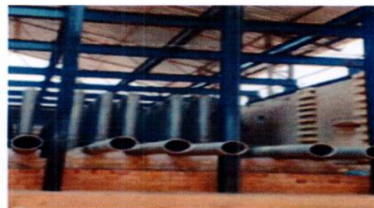
Foto 3: Vista frontal do silo de carvão
