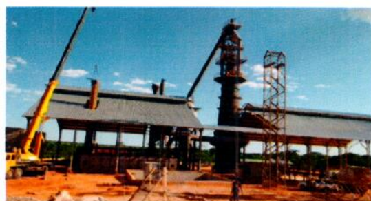
Foto 2: Montagem da infraestrutura do alto-forno
