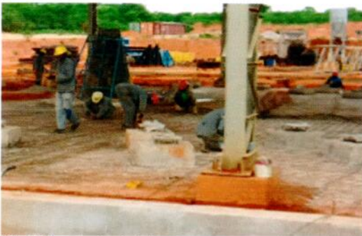
Foto 5: Construção de infraestruturas
