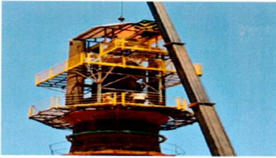
Foto 4: Montagem da chaminé do alto-forno
